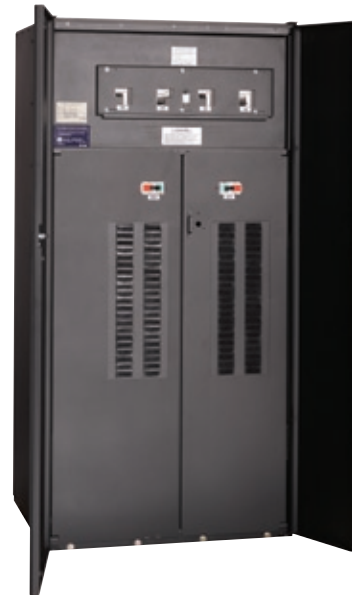
40 kVA IDC Bypass
